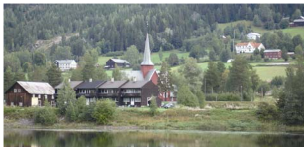
Kyrkjer er signalbygg som bør vere godt synleg i landskapet. Bagn kyrkje ligg vakkert til langs elva, men mangel på omtanke ved plassering av nyare bygningar har redusert opplevinga av kyrkja. Dette er eit døme på at plassering av bygg i høve til kvarandre kan vere vel så viktig som utforminga av bygget i seg sjølv.
