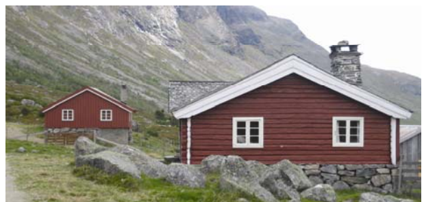
Huset i framkant er 6,5 m breitt. Skifertaket er truleg lagt oppå eit torvtak slik at tak og vindskier vart høgare. Foto: Ingrid Kvissel.
