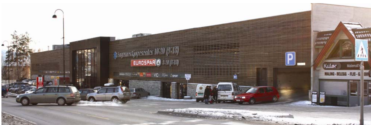
Fagernes kjøpesenter har fått ny fasade. Fasaden har sprinklar og store glas som gjer at bygget verkar meir ope. Bygget har ikkje parkeringskjellar, men eit parkeringsdekke integrert i bygningskroppen. Foto: Katharina Sparstad.
