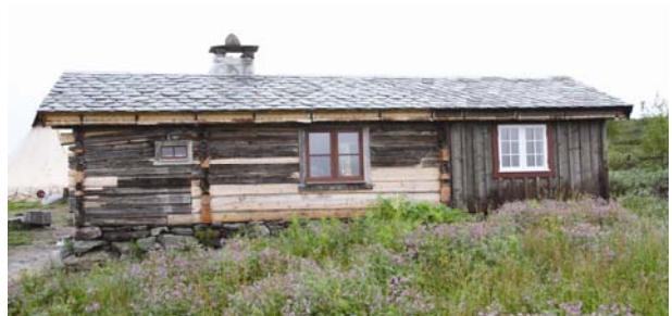
Stølshus i Valdres er vanlegvis små og godt tilpassa terrenget. Frå Kinnhølt, Vestre Slidre. Foto: Else Rønnevig.
