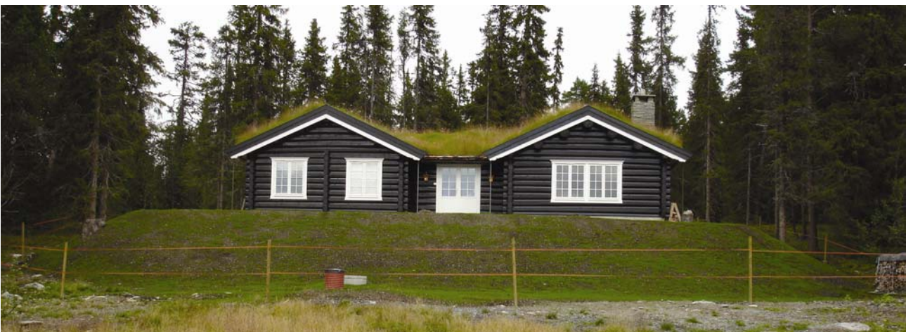
Døme på bygg som er lagt på ei stor fylling og i liten grad tilpassa terrenget.
